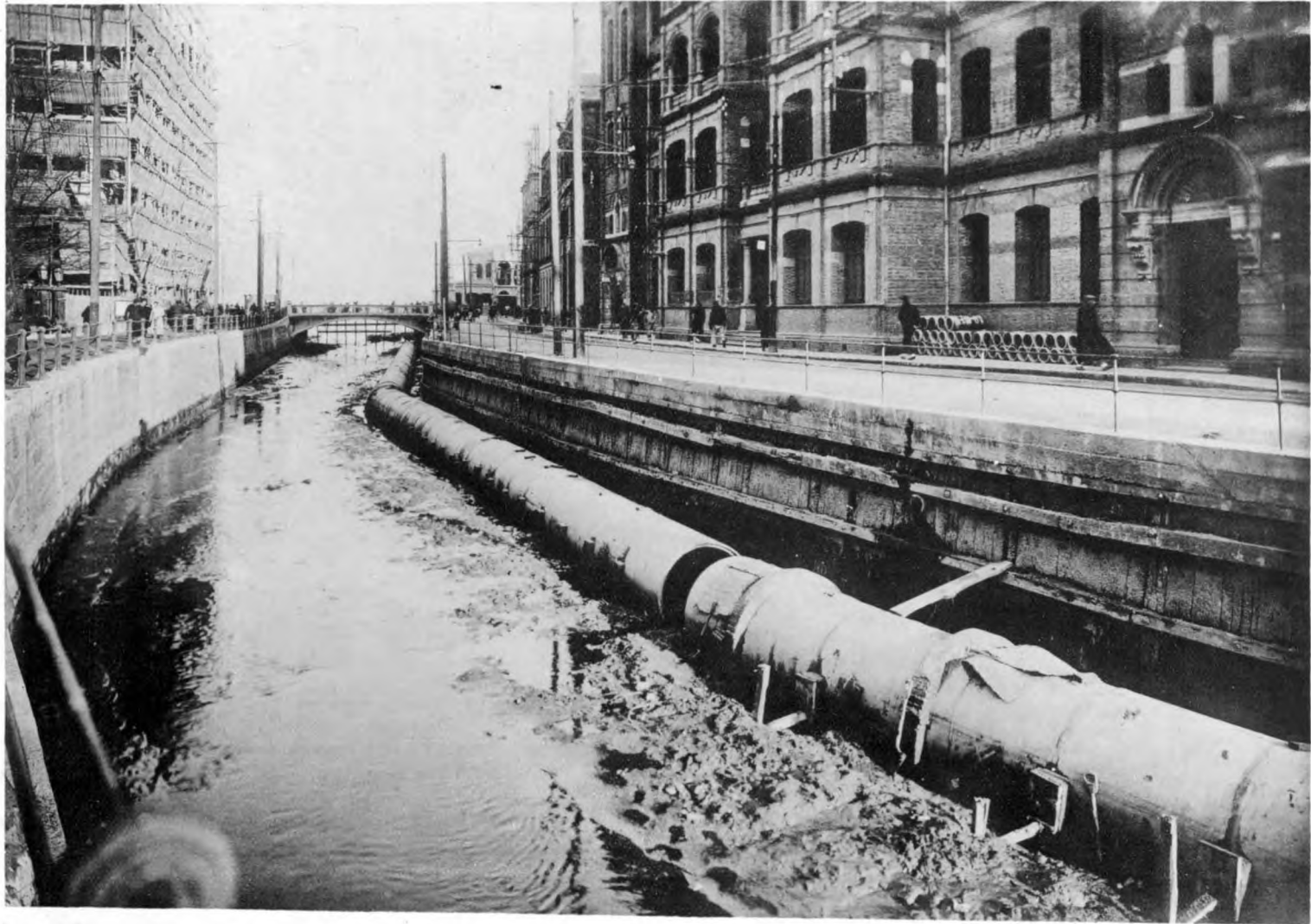
DRAINAGE DE LA CRIQUE DU YANG KING PANG
