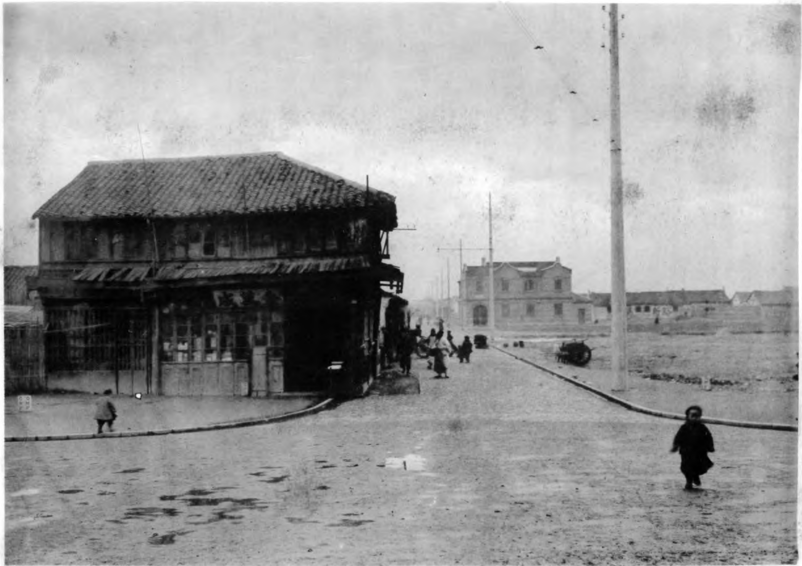
ASSAINISSEMENT DU QUARTIER SIE-MEN. — Rue Bluntschli après prolongement
