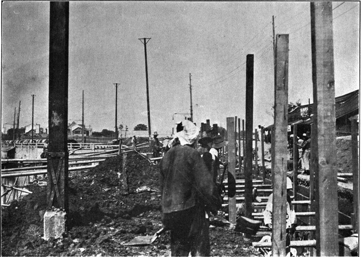
Tranchée le long de la crique de Zikawei
