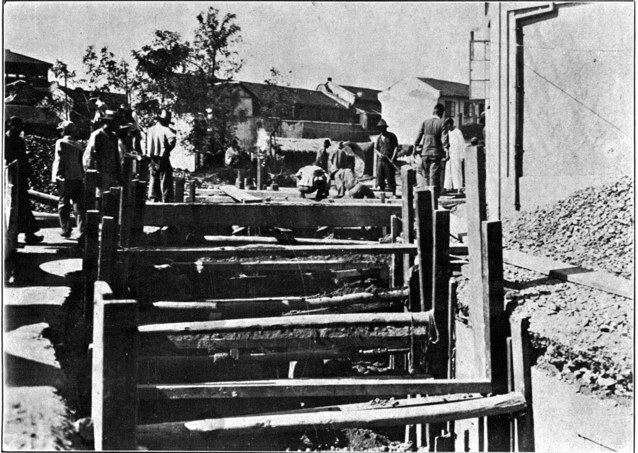
Tranchée route du Père Robert
