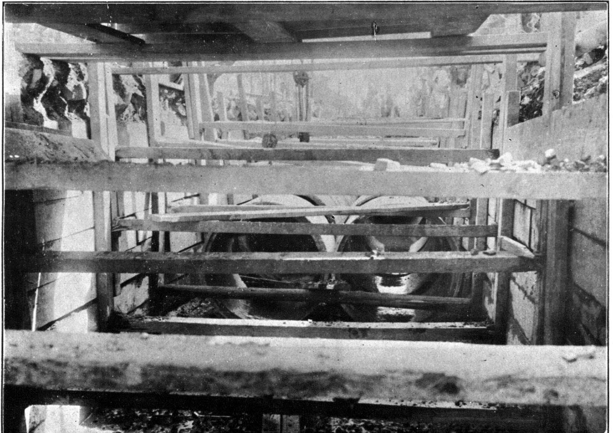
Pose des 2 collecteurs route du Père Robert
