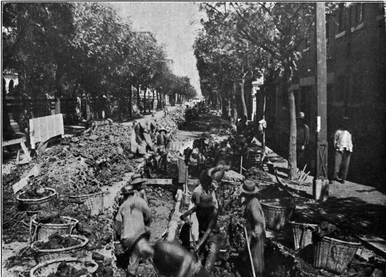
Démontage de la chaussée route Stanislas Chevalier
