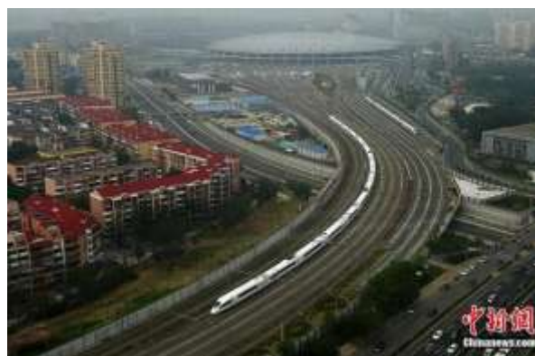
Photo 20 : Un TGV au départ de la nouvelle gare de Wuhan
