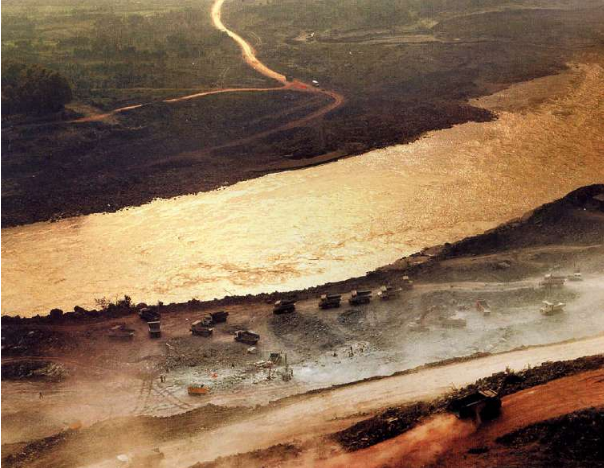
Photo 17 : Les travaux du barrage de Xiangjia (Jinsha) en cours de construction (2004)
