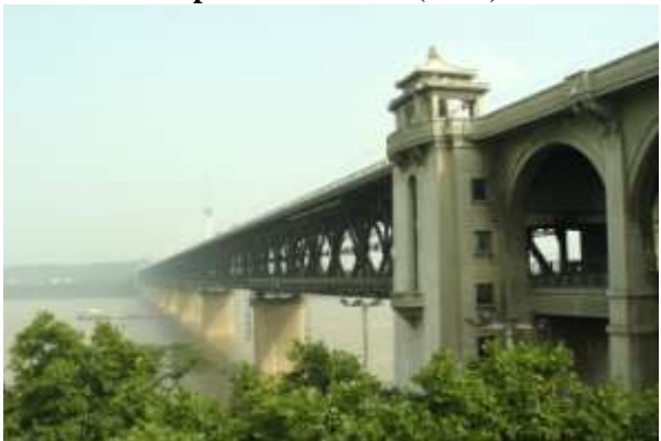
Le pont de Wuhan (1968)
